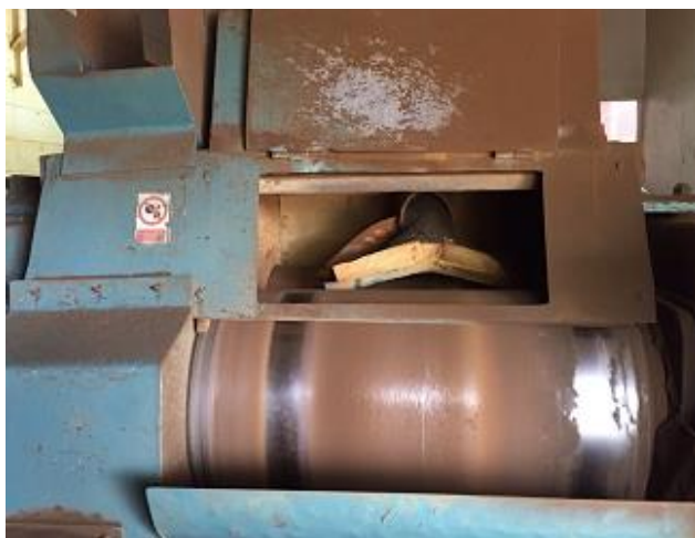
エボナイト製造設備
